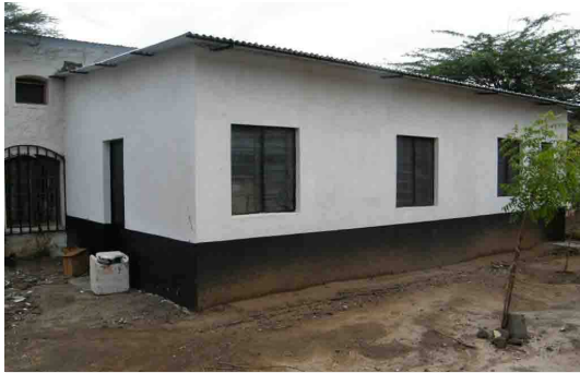
Edificio nuevo anexo al quirófano
